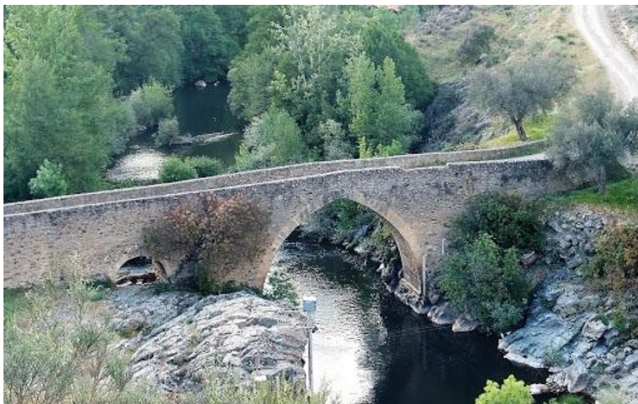
Figura 5. Ponte Velha - Pinelo, Vimioso Fonte: CM Vimioso
