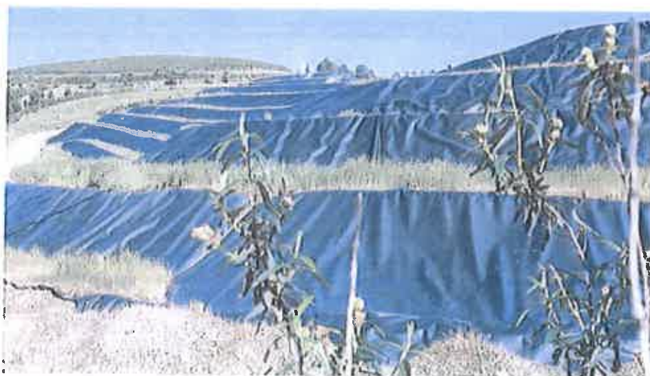
Figura 5 - Aterro Sanitário de Urjals - área selada.
